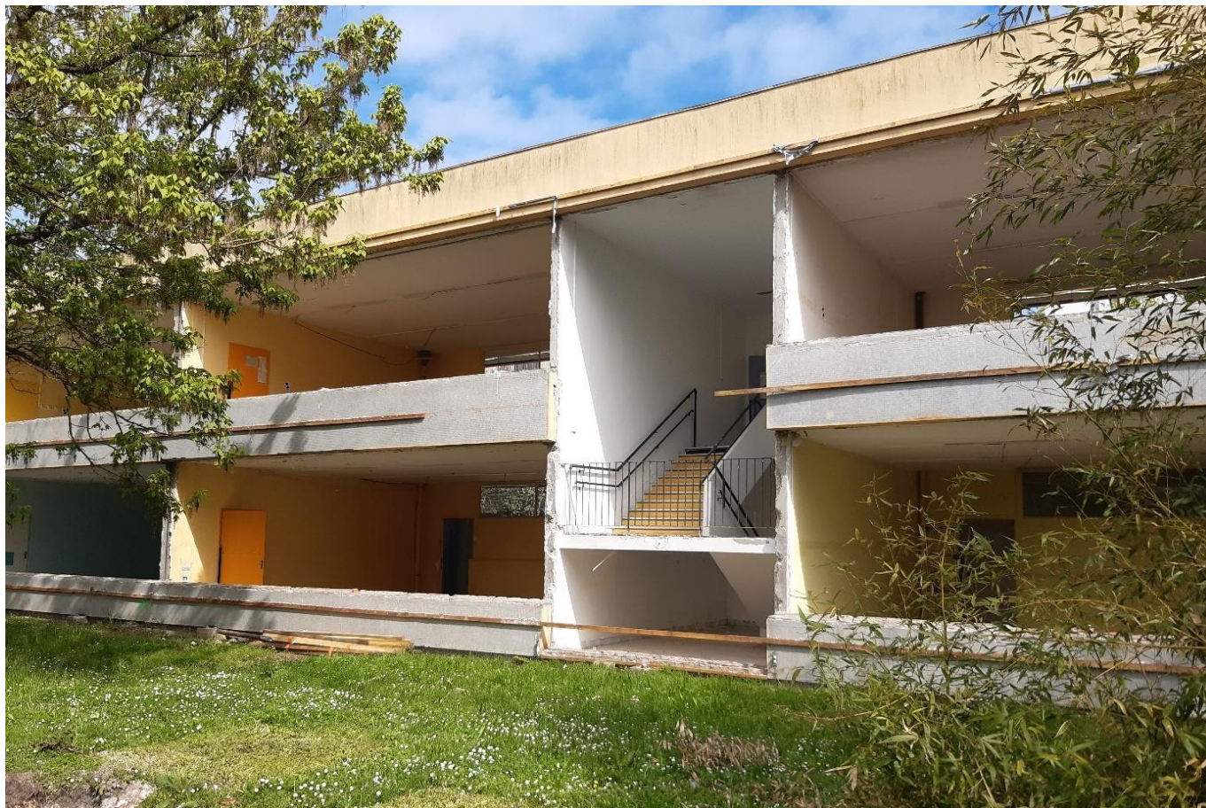
Fig. 1 école maternelle Bois-Perrier existante ©ville de Rosny-sous-Bois
