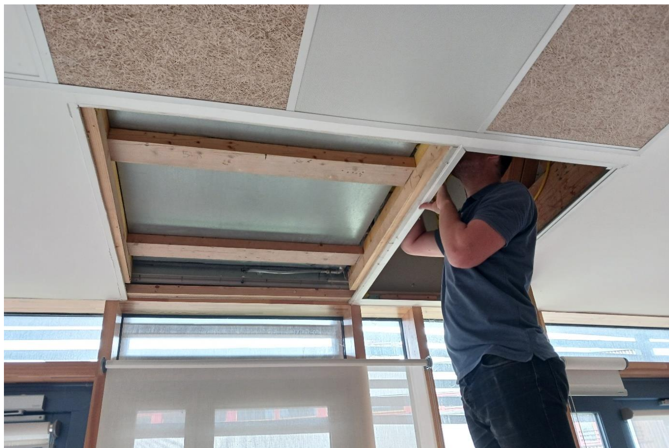
Fig. 10 visite d'entretien des échangeurs à plaques ©ville de Rosny-sous-Bois
