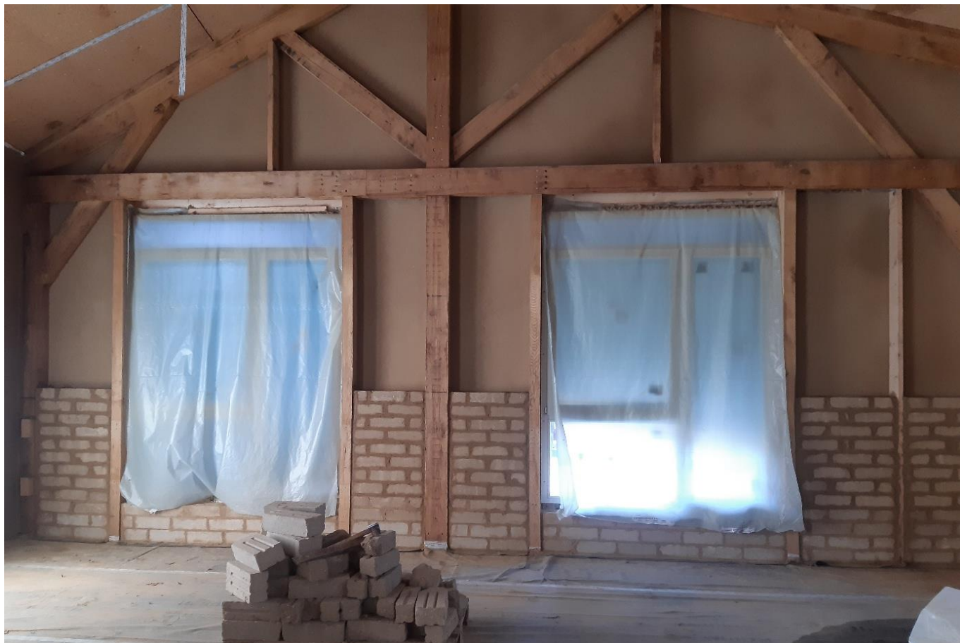
Fig. 7 Doublage et murs porteurs en terre crue, maternelle Mermoz (2024) ©ville de Rosny-sous-Bois
