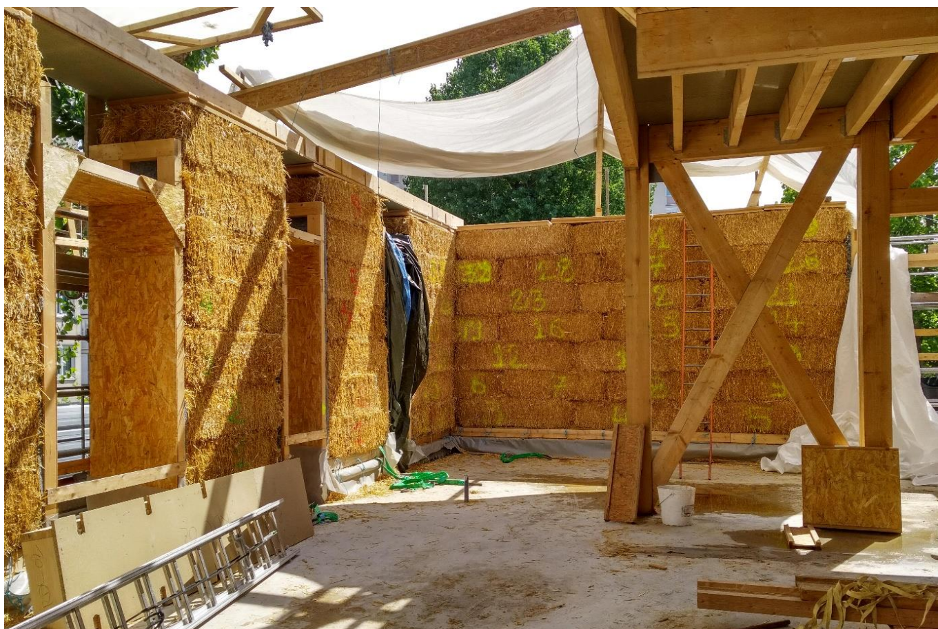
Fig. 6 Paille bio et châtaignier d'Ile-de-France pour la structure du centre de loisirs Chirac (2020) ©ville de Rosny-sous-Bois
